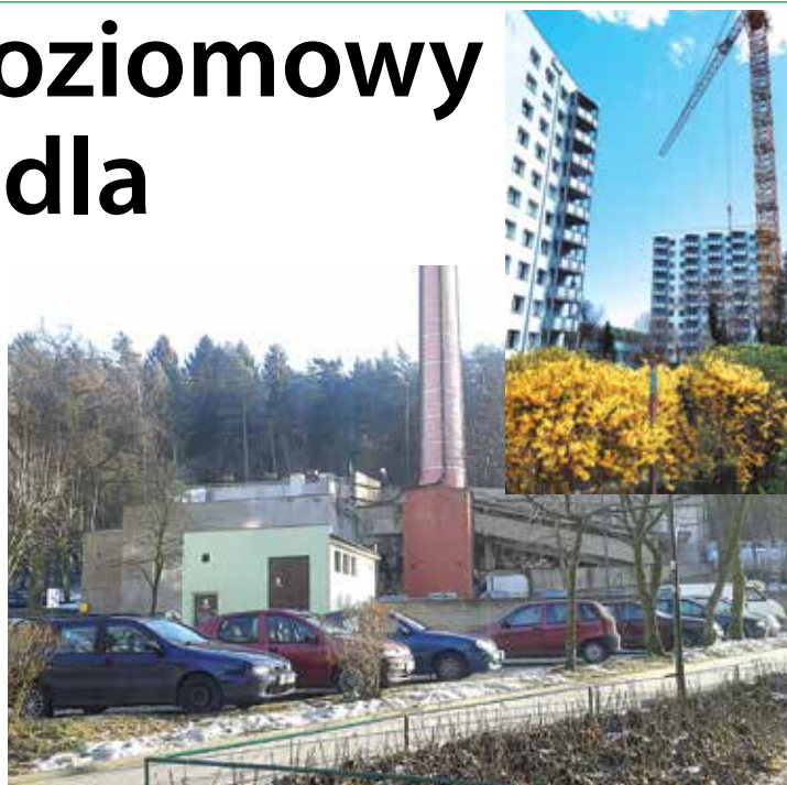
Wyburzona stara kotłownia
